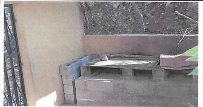
Foto 3. Estufa en mal estado no cuenta con chimenea para la salida de humo
